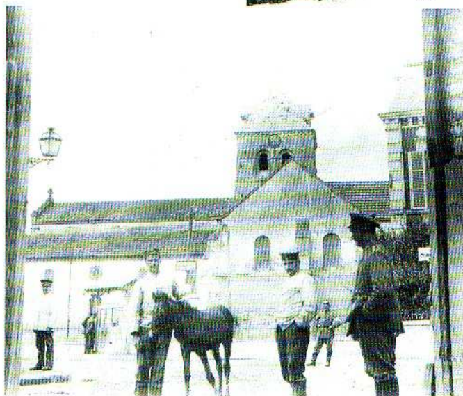
La vie paisible de l'occupant à Warméreville (coll. de l'auteur).
