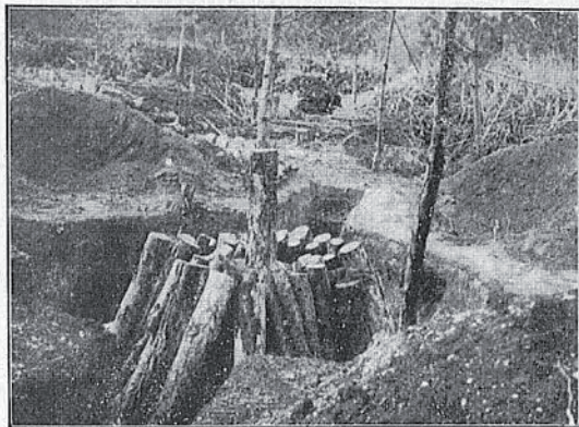
Meiler im Bau
