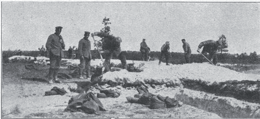
Ausheben eines Schützengrabens
