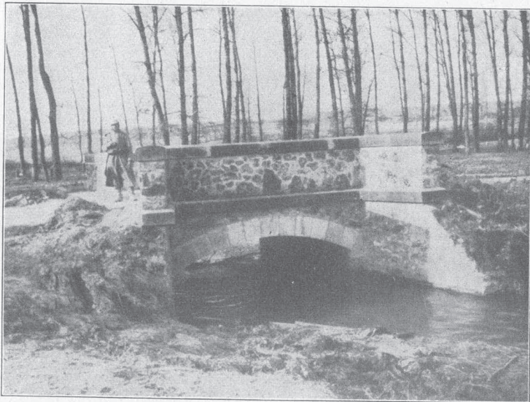
Brücke über die Dormoise bei Ripont
