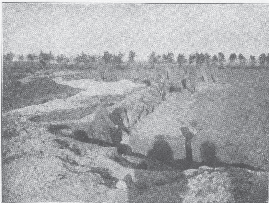
Ausheben von Reservestellungen
