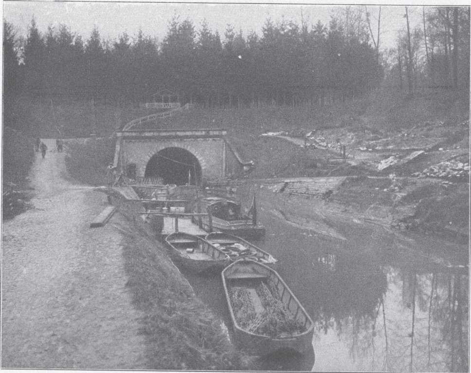
Kanaleingang bei Chevreigny
